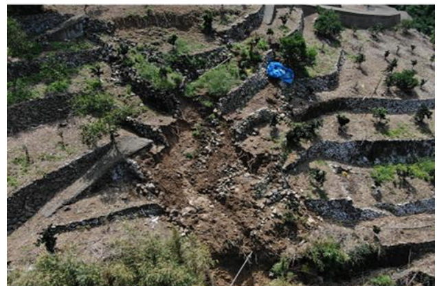
災害により崩れた畑
