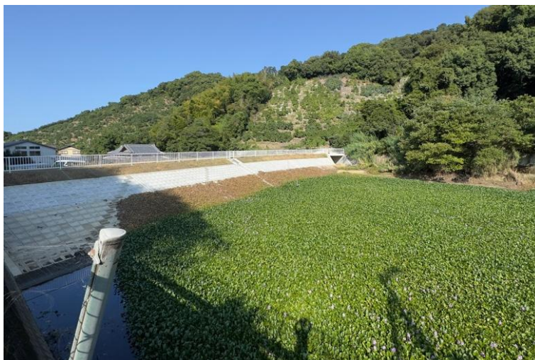
整備された護岸（農業用ため池）
