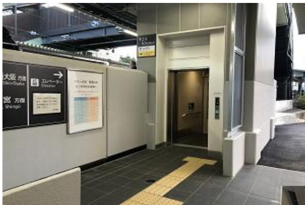
エレベーターの設置と段差の解消
