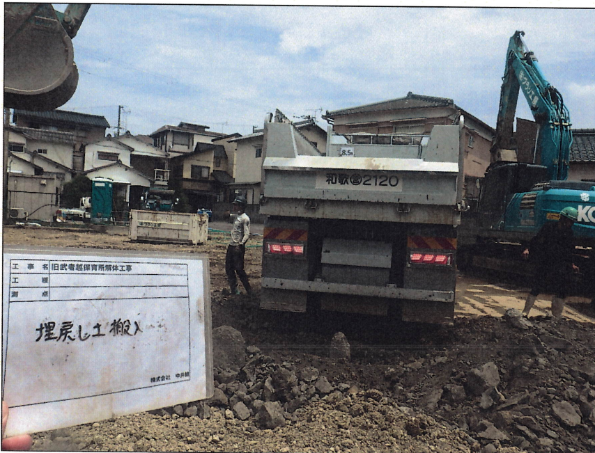
撤去跡整地工事 埋戻し 土搬入
