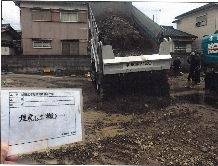
撤去跡整地工事 埋戻し 土搬入
