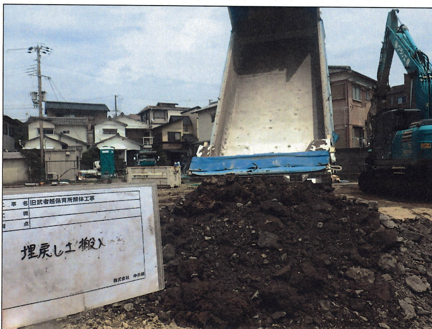
撤去跡整地工事 埋戻し 土搬入
