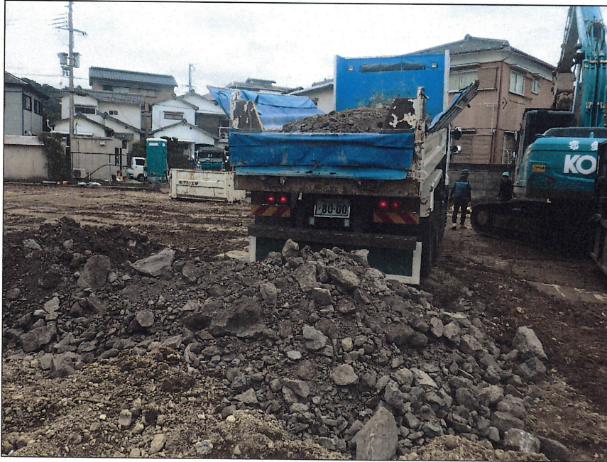
撤去跡整地工事 埋戻し 土搬入
