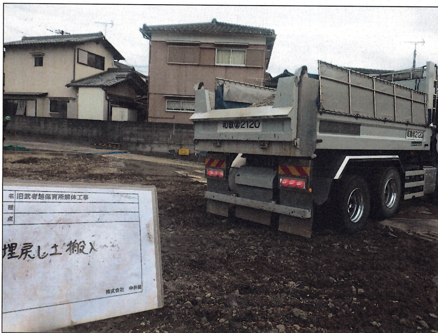
撤去跡整地工事 埋戻し 土搬入
