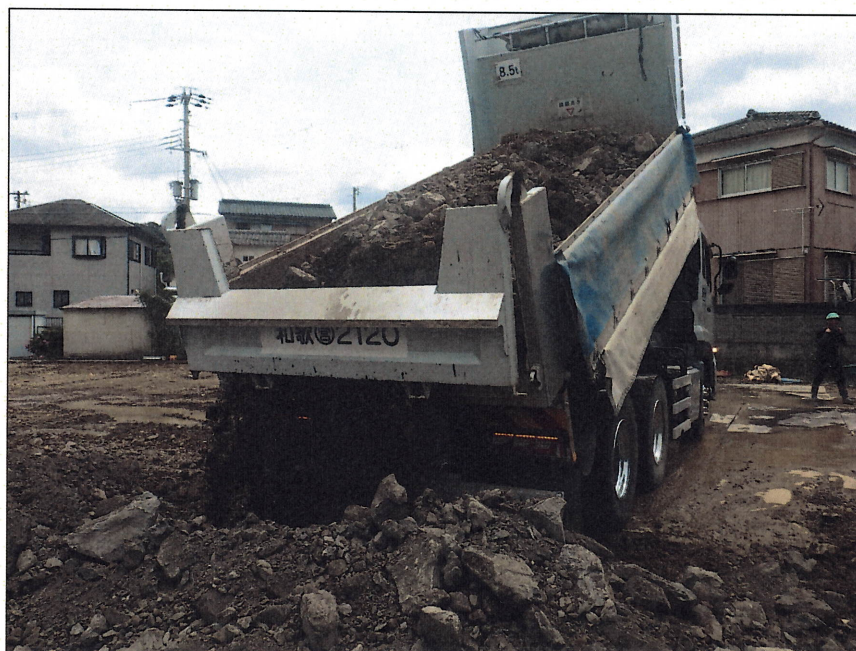
撤去跡整地工事 埋戻し 土搬入
