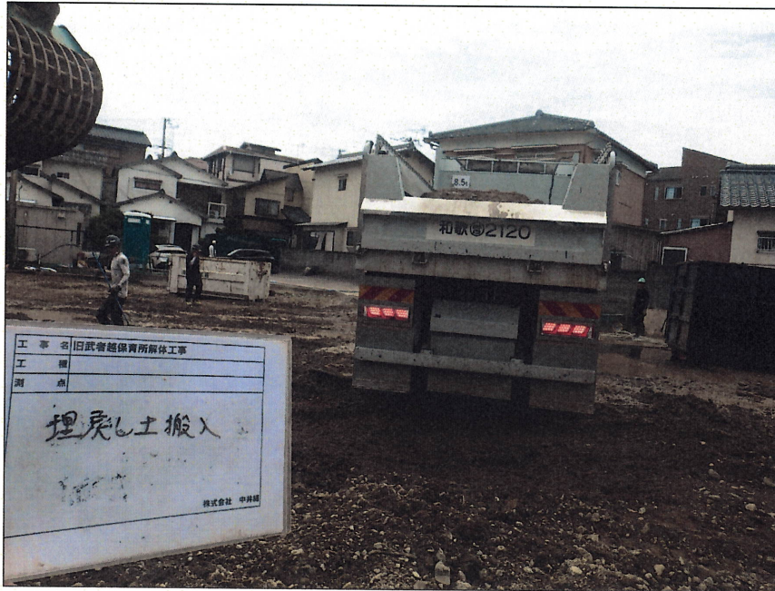
撤去跡整地工事 埋戻し 土搬入
