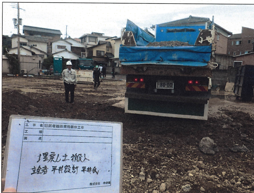
撤去跡整地工事 埋戻し 土搬入
