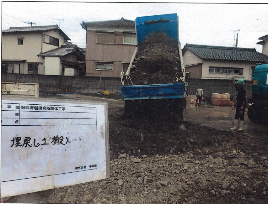
撤去跡整地工事 埋戻し 土搬入
