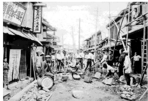
図 1-32 大宮通り拡張工事
