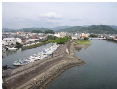
図 1-29 弁財天堀と広川
