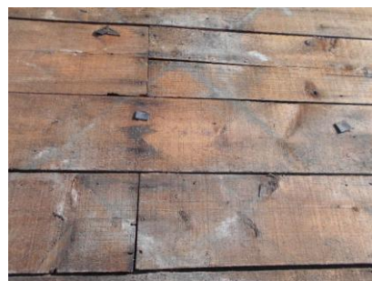
図 2-40 菱葺き屋根の痕跡
