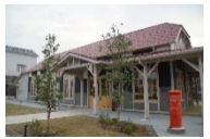
歴史的風致形成建造物の修理
