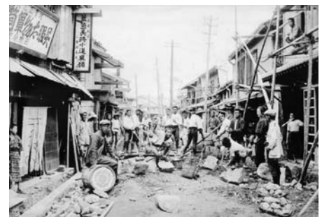
大宮通り拡幅工事
