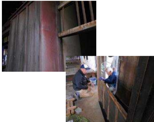
痕跡や腐食状況を確認しながらの整備
