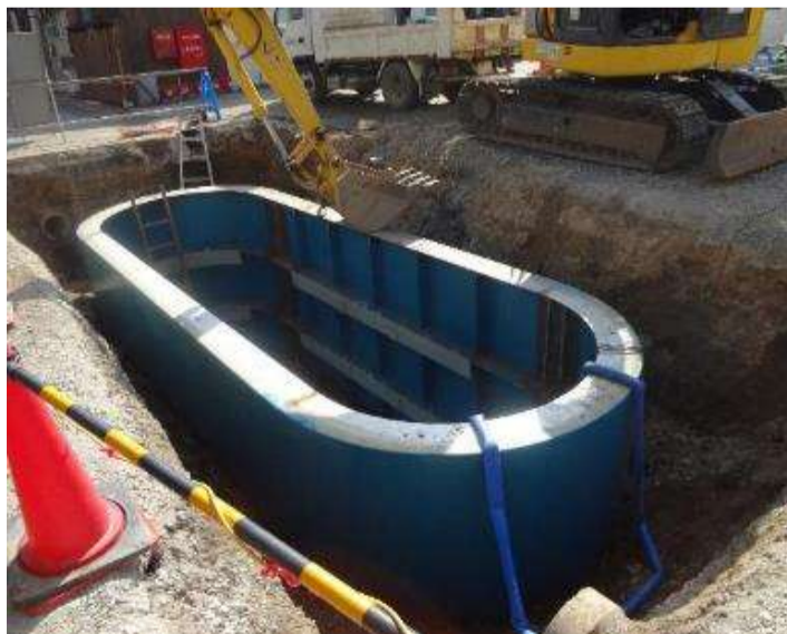
北浜町に設置した耐震性防火水槽(40トン)
