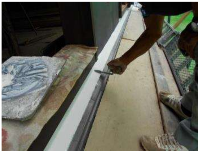
外壁の漆喰塗り作業風景
