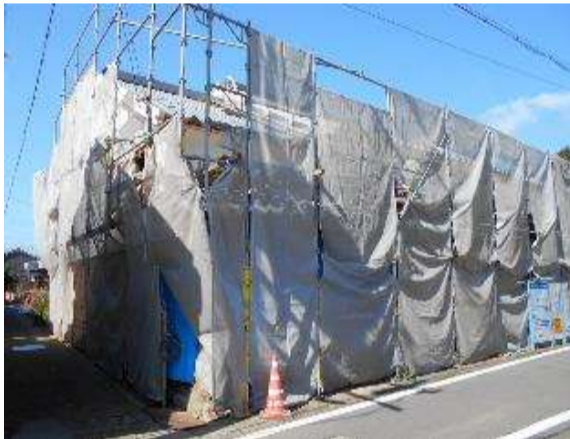
旧栖原家現況
