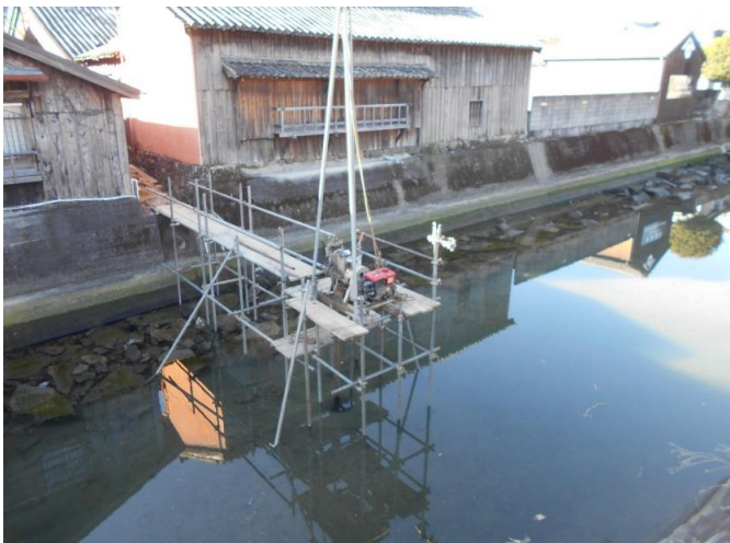
大仙堀内のボーリング調査
