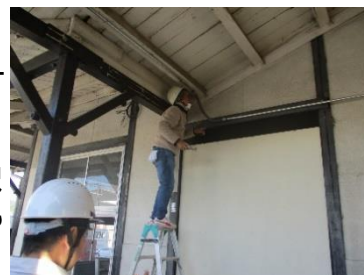
湯浅駅旧駅舎建造物調査の様子(R2)
