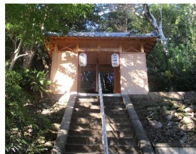
県指定史跡 逆川王子 逆川神社拝殿修理事業(H30)
