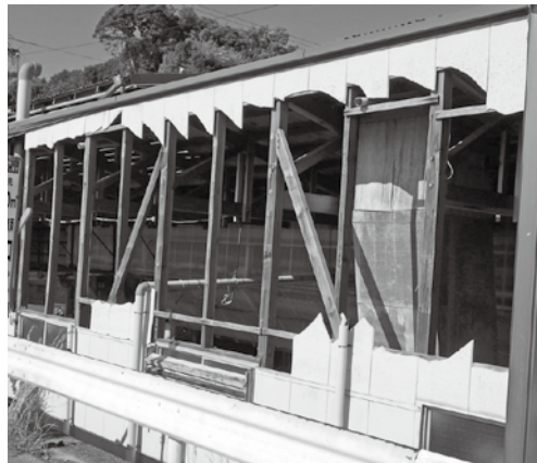
撤去予定の栖原地区空き倉庫
