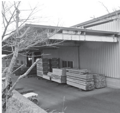
木材加工大型共同作業所
