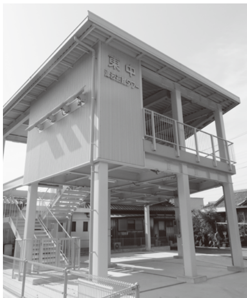
広川町東中地区津波避難タワー
