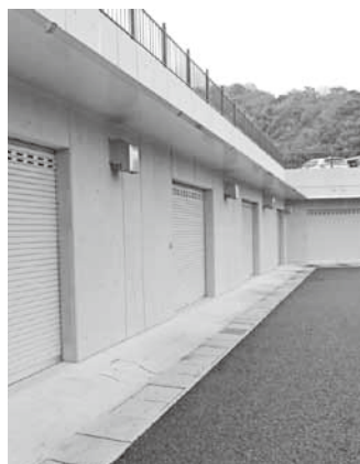
役場屋外倉庫
