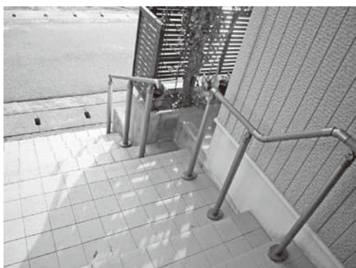
手すりを設置した玄関
