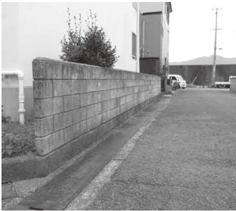
ブロック塀 (港団地)
