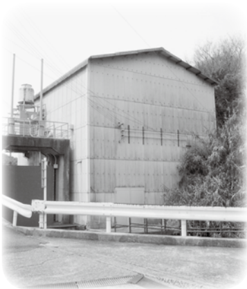
▲栖原ポンプ場
