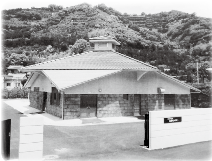
▲浄化センター（田地区）
