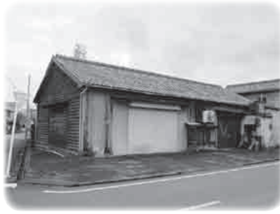
改修前の観光情報センター（漁協付近）
