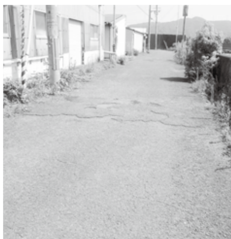
町内各道路改修（なぎ区漁港周辺）
