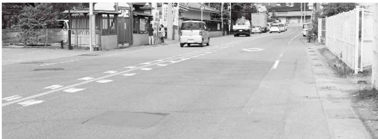
7ヶ所のマンホールを改修（顯國神社前県道）
