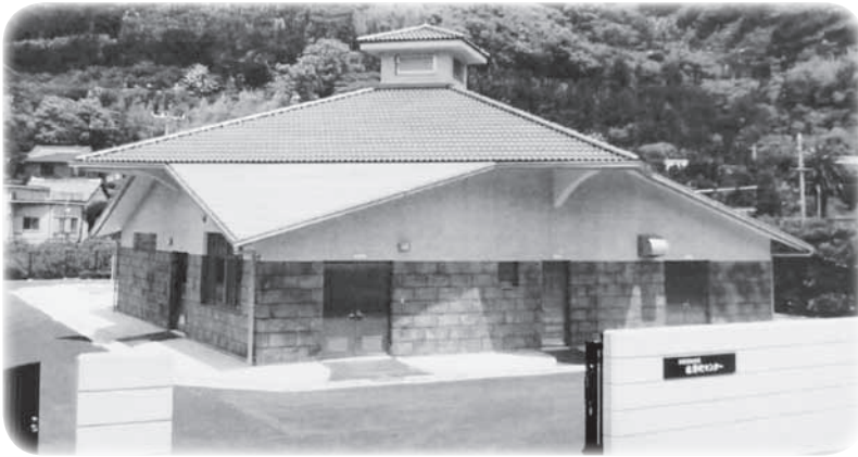
田浄化センター
