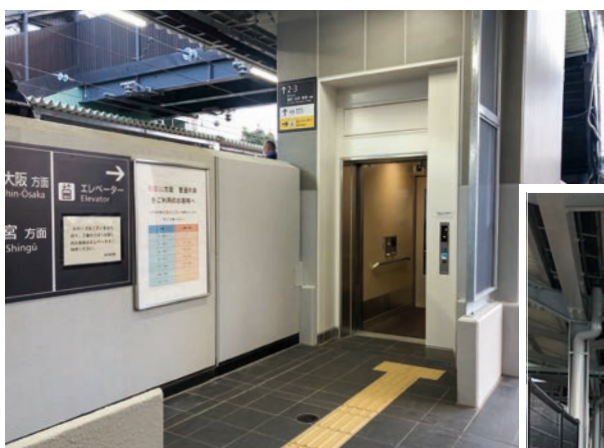
エレベーターの設置と段差の解消
