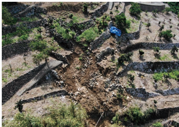
災害により崩れた畑
