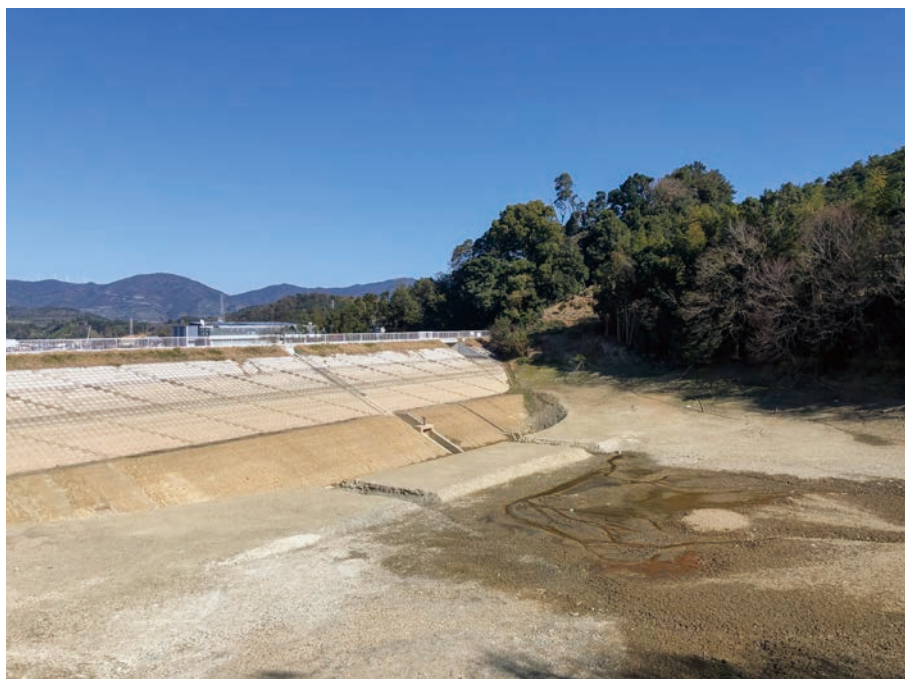
整備された護岸（農業用ため池）
