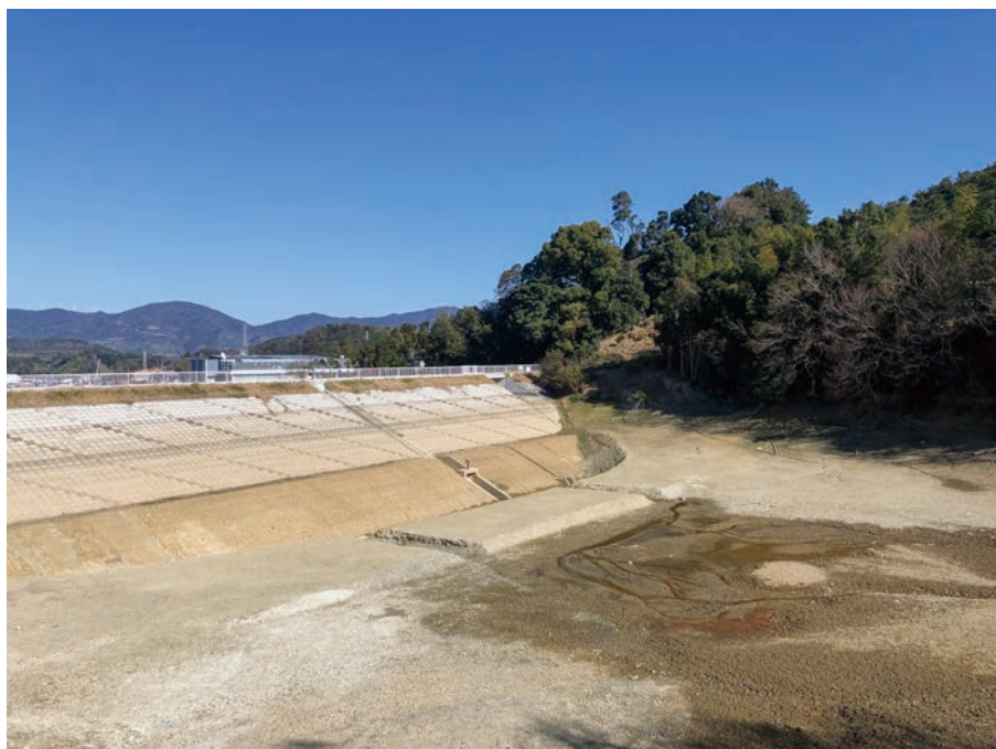
整備された護岸（農業用ため池）
