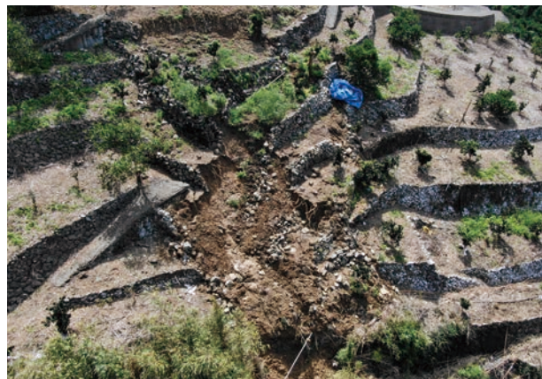
災害により崩れた畑
