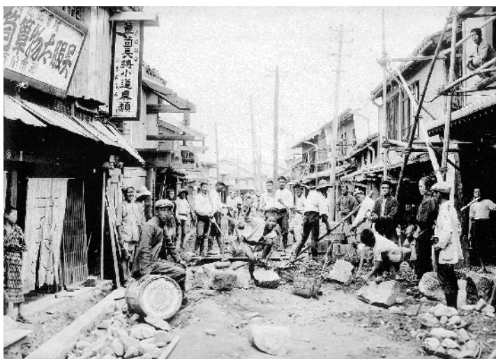
◀ 道路の拡幅工事（明治）
