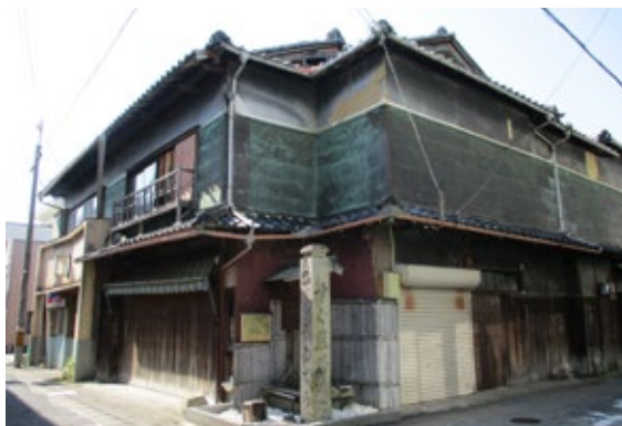
写真14 銅板で仕上げた壁が特徴的な町家
