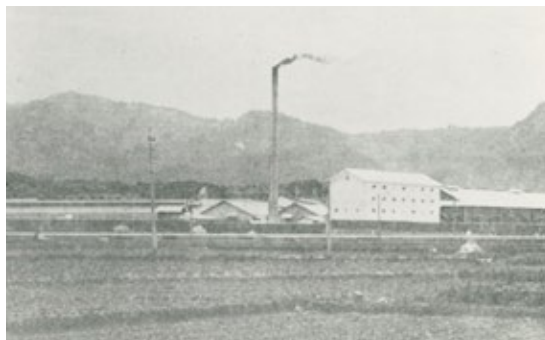
写真71 丸万製糸工場
