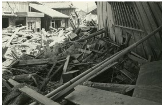
写真72 第2室戸台風の被害（栖原）
