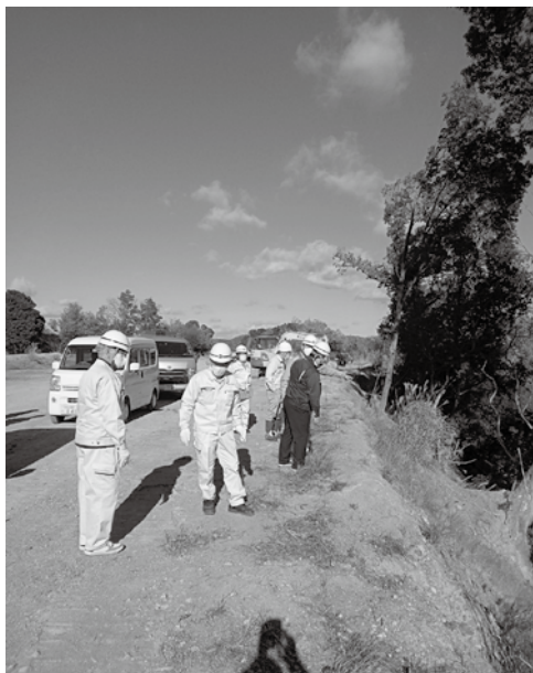
山田地区違法盛土箇所
