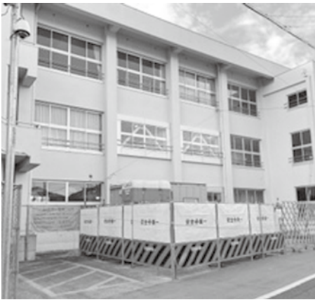
湯浅小学校学童保育所改修工事現場
