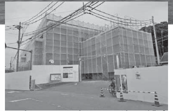
▲令和元年11月の工事の様子
