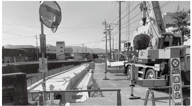
張り出し歩道現場
