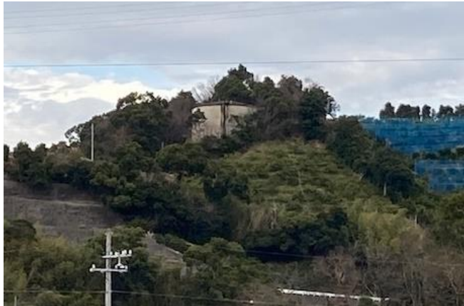
方津戸配水池
