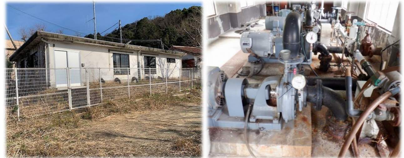
久米崎配水池・ポンプ場（地下に配水池）
