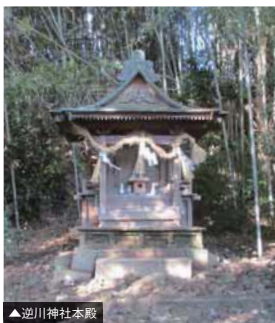
▲逆川神社本殿
