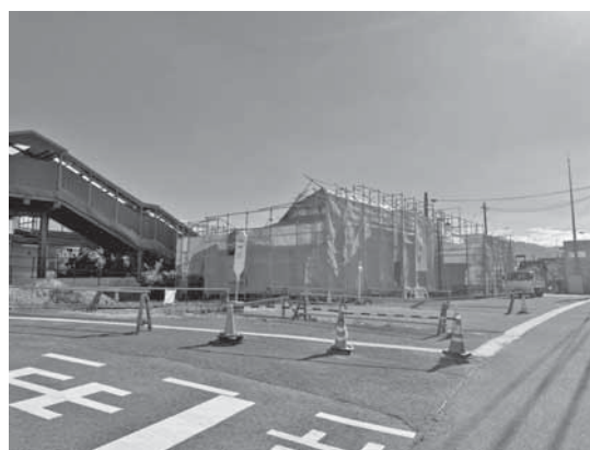
工事の様子(10月末時点)
