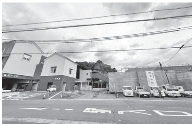
湯浅えき蔵と改修中の湯浅駅旧駅舎
