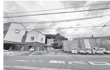
湯浅えき蔵と改修中の湯浅駅駅舎
