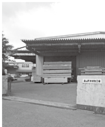
木材加工大型共同作業場
