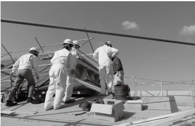
湯浅駅旧駅舎屋根部分
