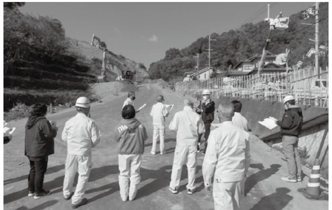
町道栖原 35 号線道路
