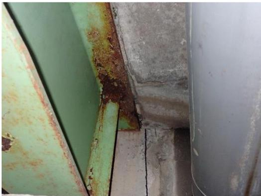
図 2-3 主桁 (腐食)
