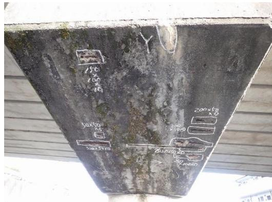
図 2-4 下部構造 (剝離・鉄筋露出)
