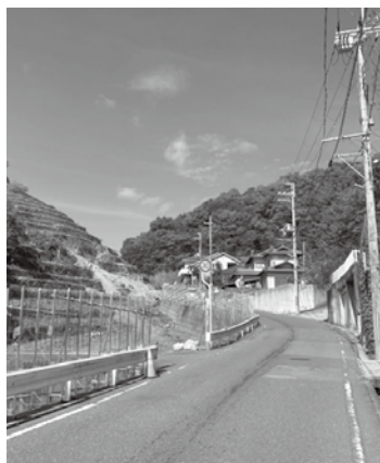
町道栖原 35 号線道路
