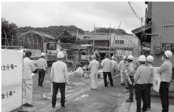
特定空家撤去現場
