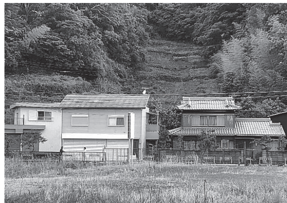
大雨による被害
