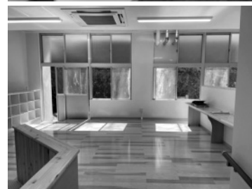
改修した山田小学校空き教室
