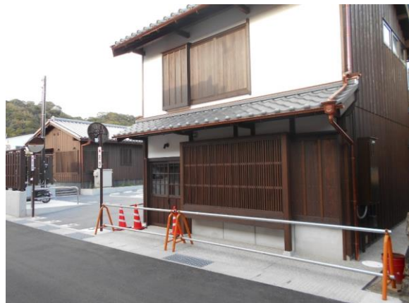
新築修景工事により完成した休憩所
