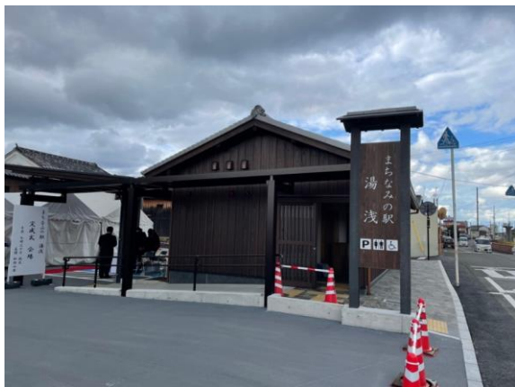
駐車場・トイレの完成・まちなみの駅 供用開始
