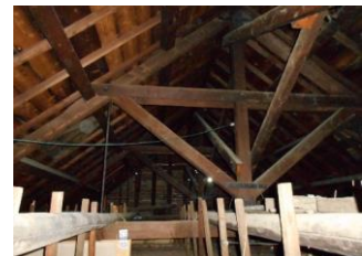
小屋裏から三角ドーマ窓痕跡
